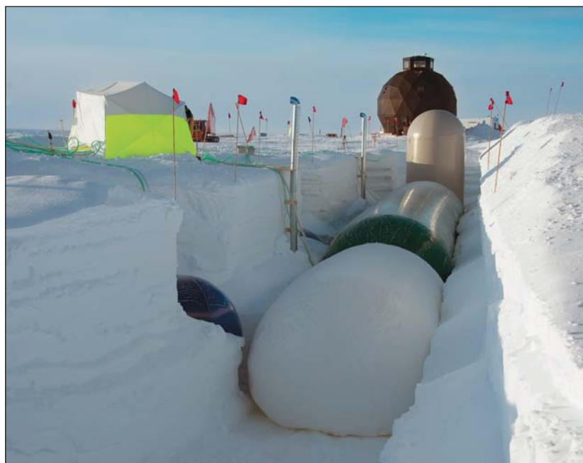
Надувные баллоны, уложенные в траншею и готовые к засыпке.
