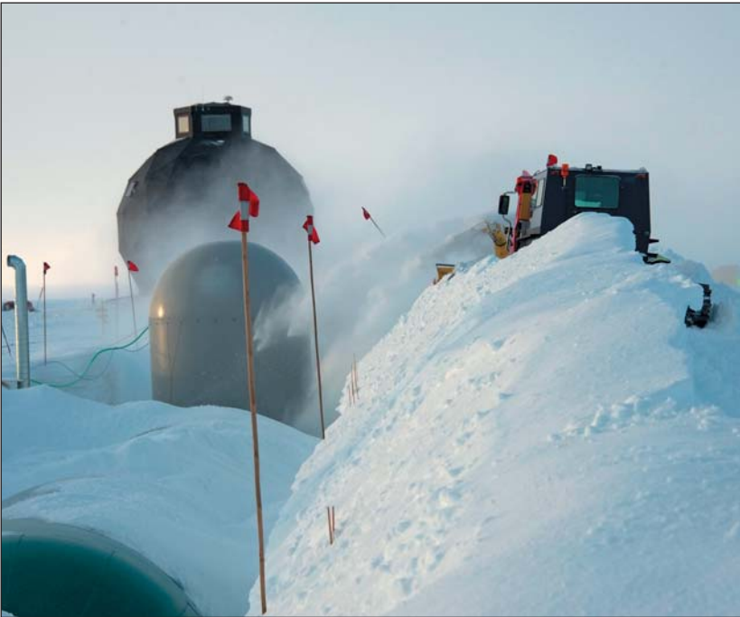
Строительство кровли траншей. Баллоны забрасываются снегом.
