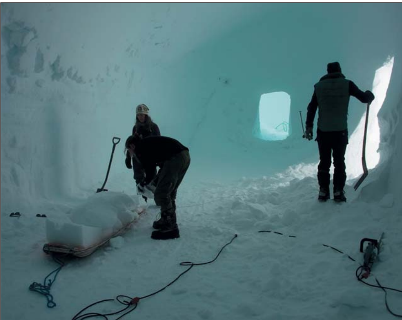
Выравнивание стен и пола внутри готовых траншей.
